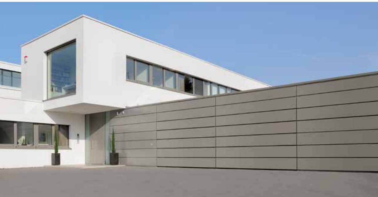
Okładzina z aluminiowych płyt zespolonych wykonana przez inwestora
